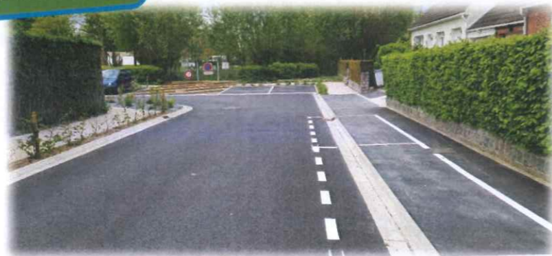
Travaux rue du Calvaire
